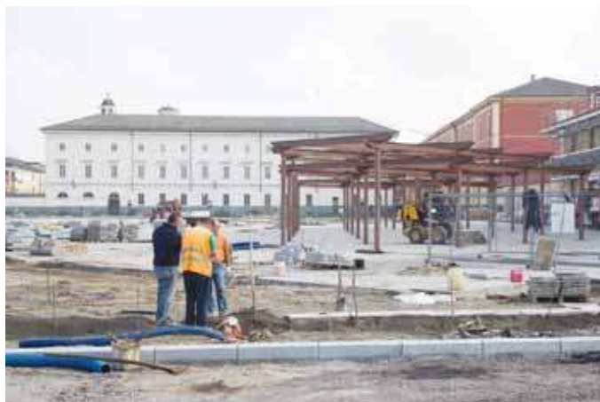
Lavori in corso nel cantiere dell'ex Foro Boario.
